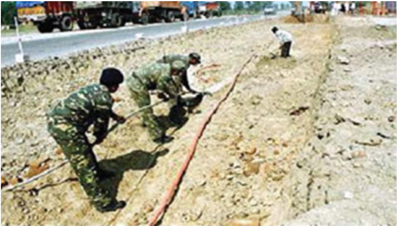
प्रगति अधीन टेलीफोन केबल बिछाने का कार्य
