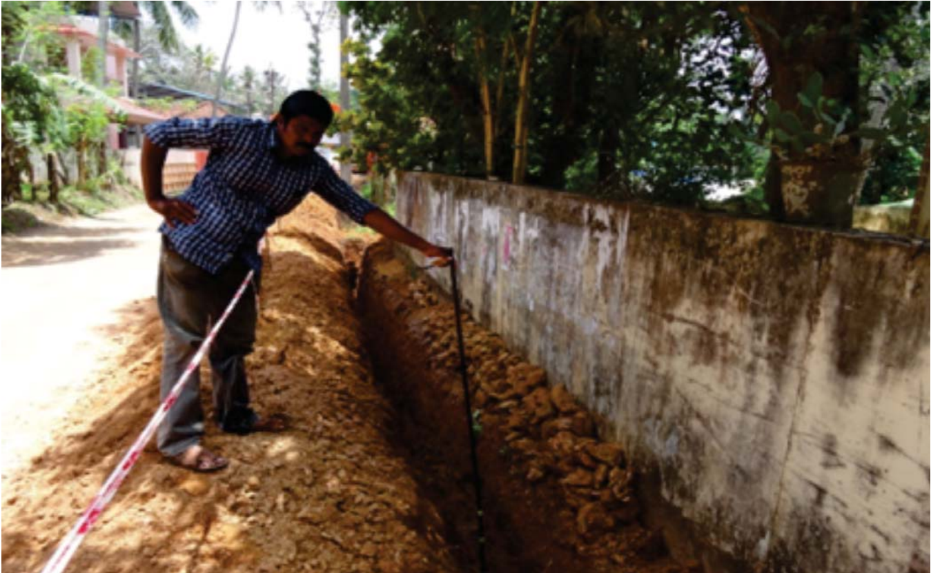
प्रगति अधीन ऑप्टिकल फाइबर केबल बिछाने के लिए खुदाई का कार्य
